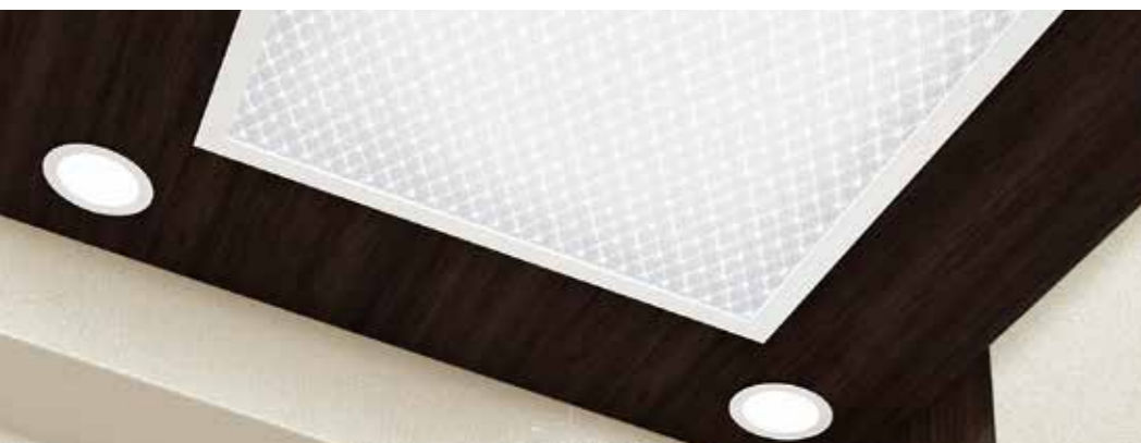
天井：彩粧鋼板+壓花壓克力照明板+嵌燈 照明型式：直接照明（白色LED燈）LED
